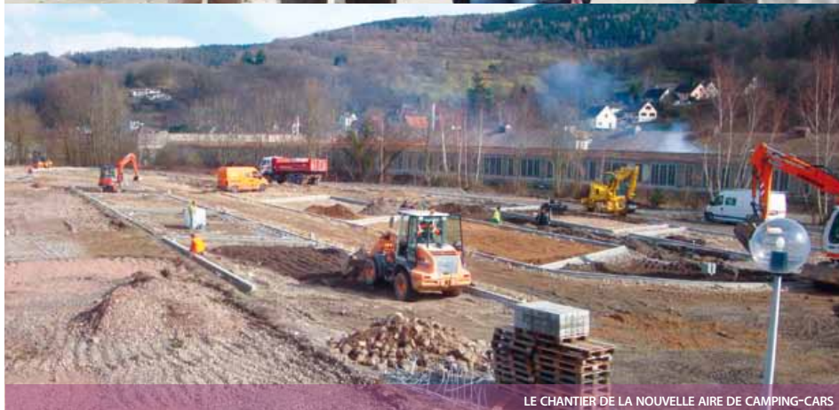
LE CHANTIER DE LA NOUVELLE AIRE DE CAMPING-CARS
