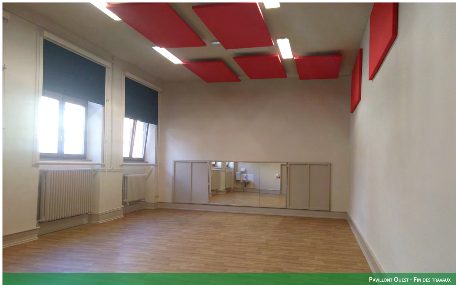
PAVILLON OUEST - DÉBUT DES TRAVAUX
